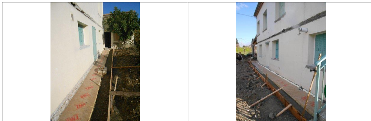
Figure 15 : Exemples d'isolation périphérique horizontale
